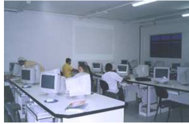
Figura 10. Falta de projeto diferenciado de iluminação que atenda às várias atividades concomitantes (projeção, escrita no quadro, anotação dos alunos).
